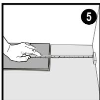
Terminata la prima fila, metti un distanziatore al muro e misura la lunghezza necessaria per tagliare correttamente la tavola da posizionare.
