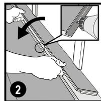
Rimuovi il dente verticale dell'incastro con uno scalpello. Metti della colla sulla linguetta orizzontale dell'incastro e unisci le tavole orizzontalmente. Posiziona alcuni distanziatori tra l'ultima tavola e il muro.
